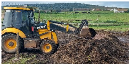
Construção pilha compostagem
